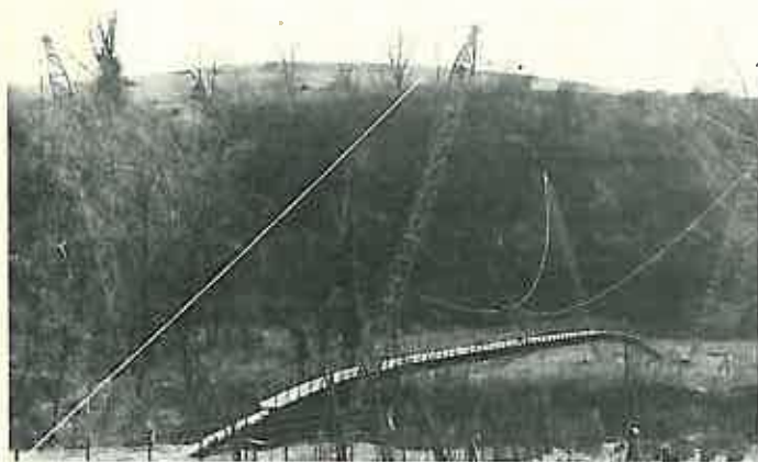
L'acquedotto delle Langhe in fase di costruzione
